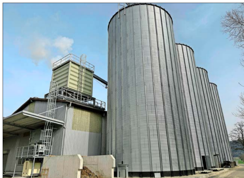
Je 900 t fassen die neuen Silos zur Lagerung der Holzpellets.
